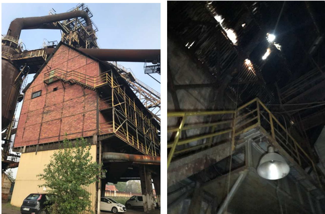
fot. elewacja oraz dach sterowni
